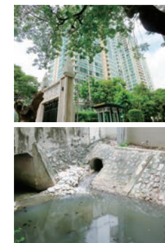
コンドミニアムと都市河川への排水の排出
