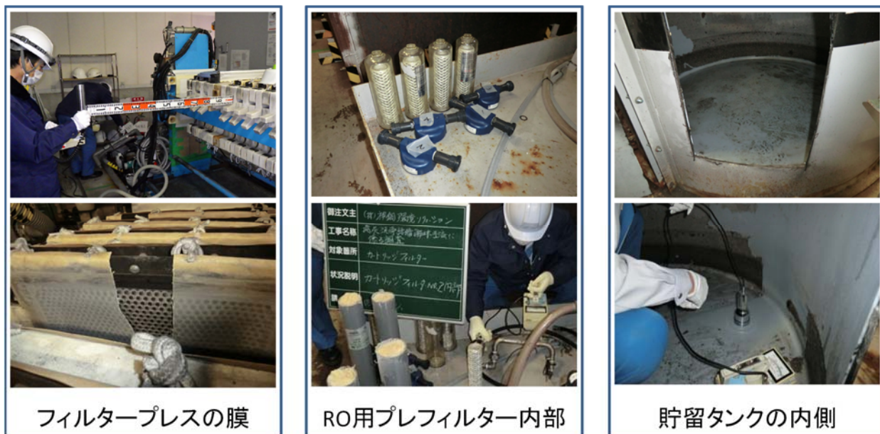
図 1.2-4 設備汚染検査の実施状況
