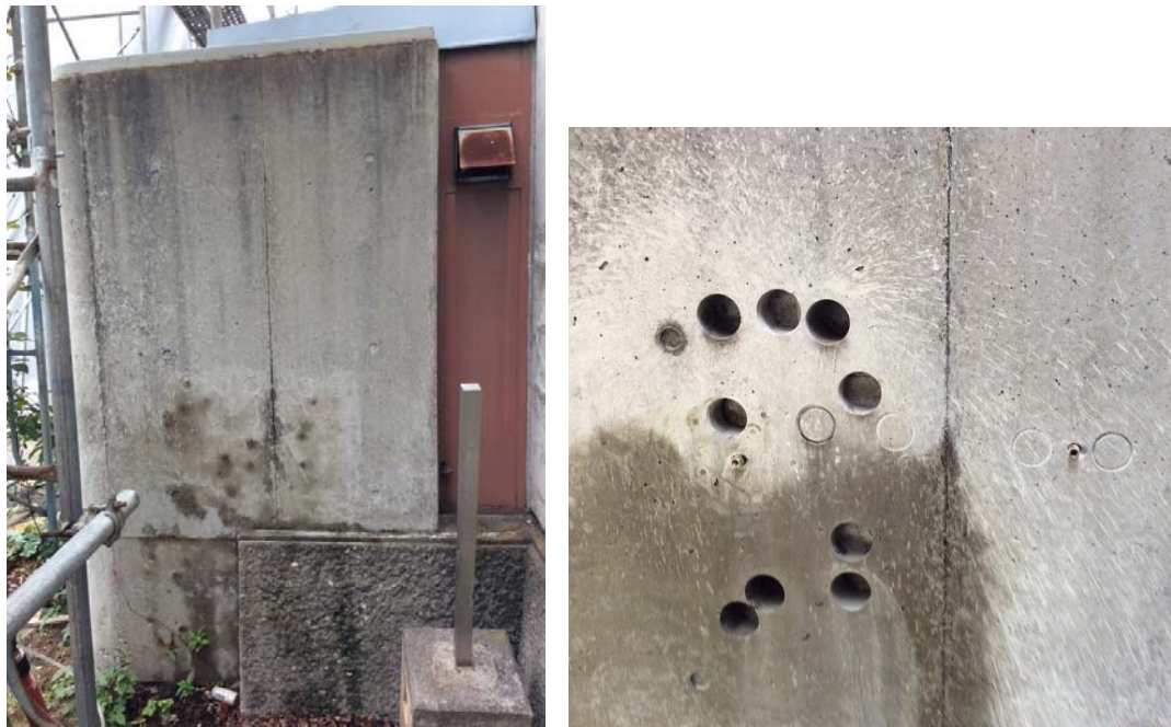
図 1.3-19 側面外壁からのコア採取の様子(シリーズ C)
