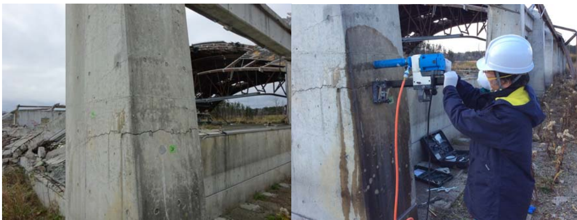
図 1.3-8 コンクリート柱からのコア抜き作業
