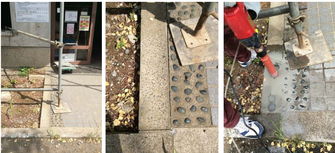
図 1.3-18 玄関の土間からのコア採取の様子
