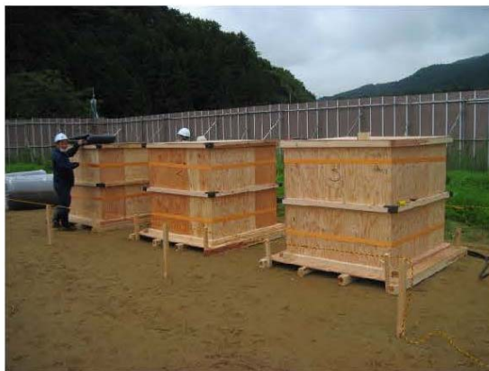
写真 1.5-12 設置作業状況
