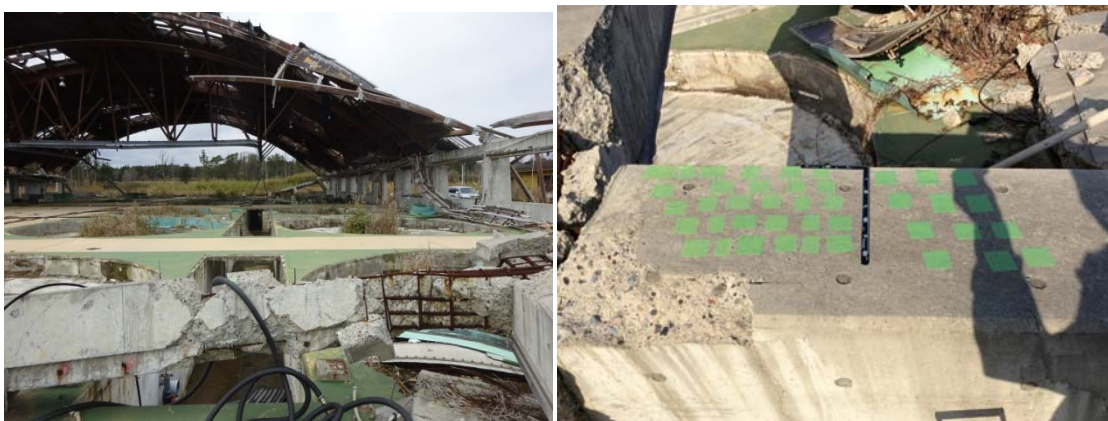
図 1.3-11 倒壊した柱
