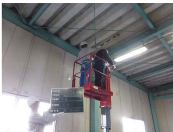
図 1.2-3 高所の汚染検査の様子
