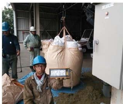
写真 1.5-6 フレコン作製状況
