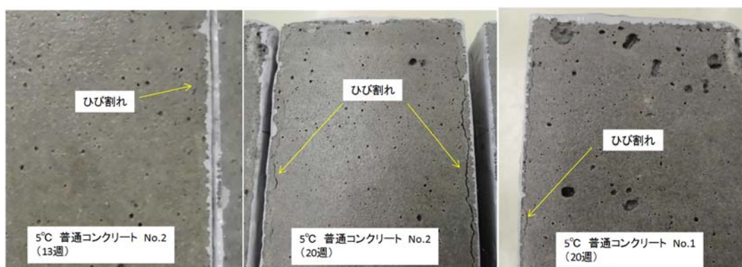
図 1.4-35 普通コンクリート (5℃) のひび割れの発生状況 (左 : 13 週、中央、右 : 20 週)
