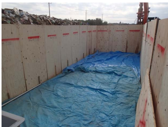
(a) 仮置場内に設置した仮設枠
