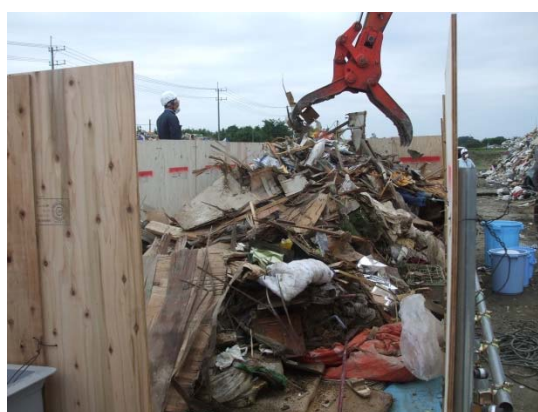
(b) 重機による災害廃棄物の投入状況
