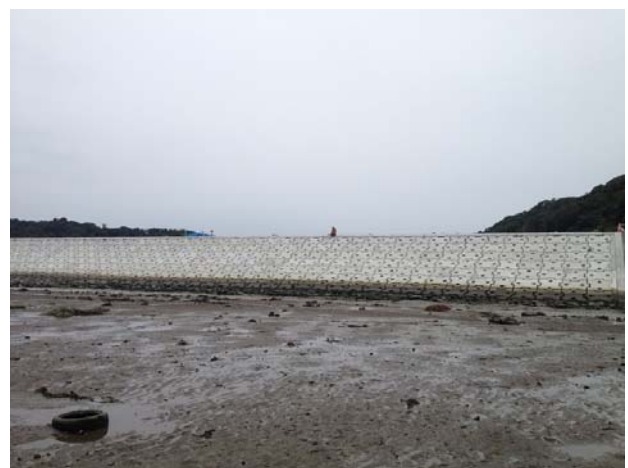
図 2.2-16 干潟への防潮堤建設。宮城県東松島市波津々浦（高さ T.P. 6.4m）
