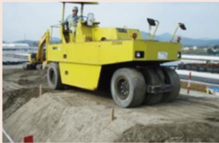
4 処理土転圧状況
