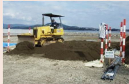
3 処理土敷き均し状況
