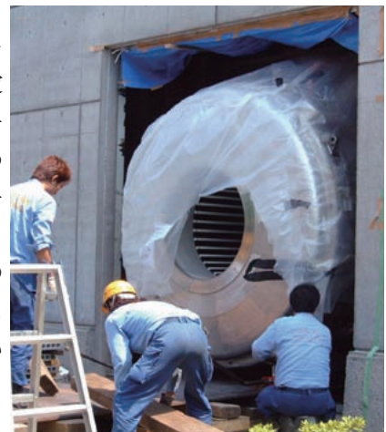
MRI 磁石の設置棟への搬入 (2001 年)
