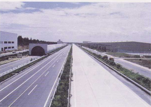
写真70 旭土木研究所横断陸橋南
