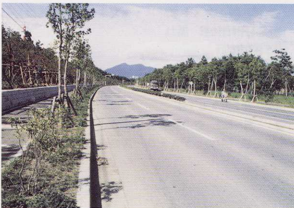
写真37 南原3 国道408号交差点北西角
