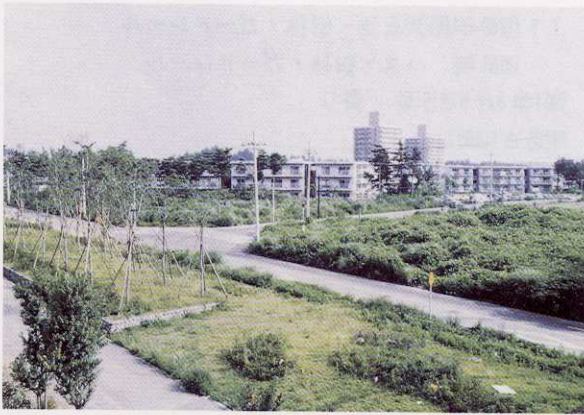
写真5 7 並木大橋歩道橋中央
