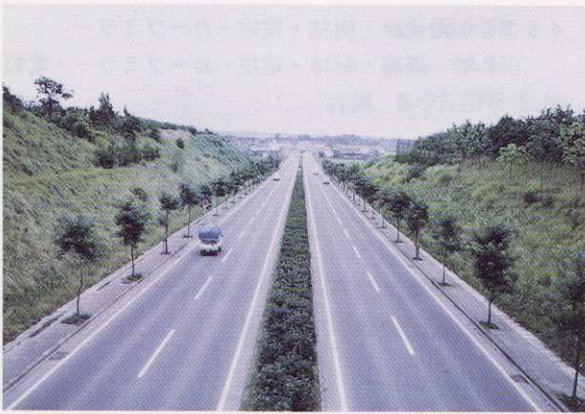
写真13 花室八坂神社南花室跨道橋
