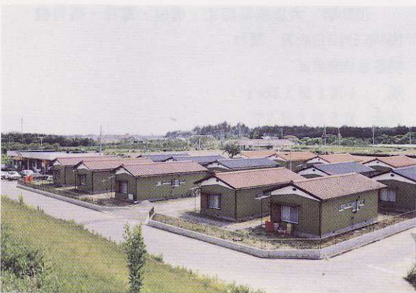
写真 7 3 筑波大学松美橋南
