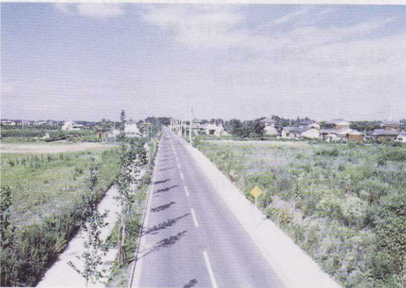
写真47 二の宮1丁目二の宮公園北東歩道橋
