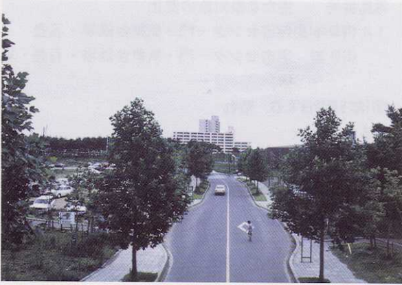
写真40 筑波大学追越看護婦宿舍西歩道橋
