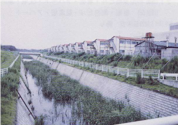
写真 6 0 観音台 3 丁目 農業環境技術研究所 第 3 連絡橋
