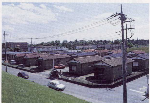
写真 7 3 筑波大学松美橋南
