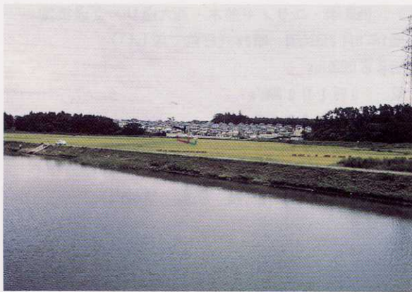
写真 7 8 荃崎町房内房内橋西
