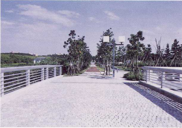
写真67 二の宮1丁目二の宮公園北東歩道橋
