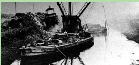
8号地処理場のごみ揚陸状況(昭和25~27年頃)
