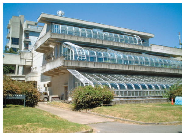
■ 図3 バイオトロン外観
