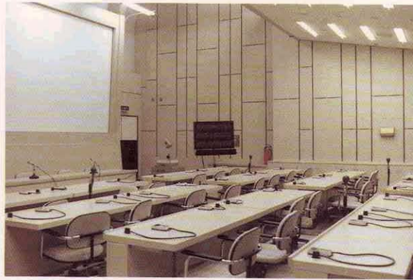
人間環境評価実験施設に取付けられた回答器 と表示盤、視聴覚機器
