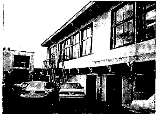
写真 3 2階建てに改装された福富町役場 (1993年12月撮影) Photo.3 Reconstructed Fukutomi town office building of two storied, as on December 1993.
