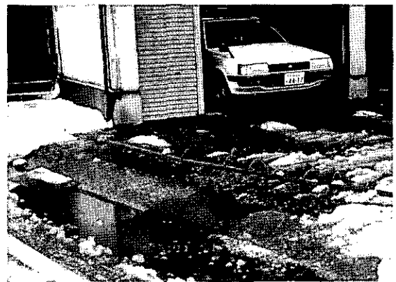
写真 3 高田市街地にある駐車場に敷設されている消雪パイプ (1994年2月撮影)
