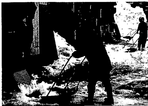
写真 4 新井市に設置されている流雪溝（1985年2月撮影） Photo.4 The ditch for washed away snow with water in urban Arai, Takada Plain, in heavy snowfall, 1985.
