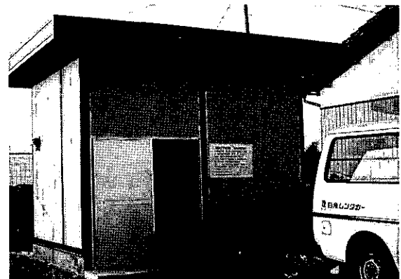
写真 2 有明東小学校内に設置された新有明観測所 (1988年10月撮影)
