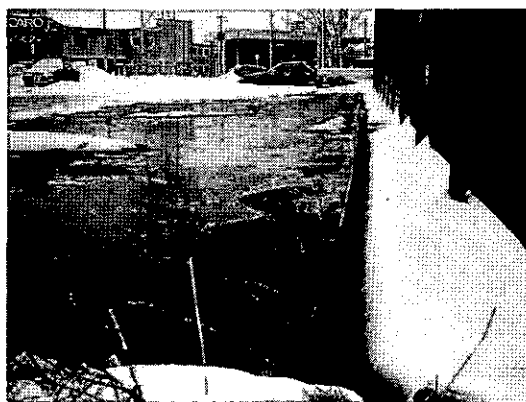
写真 4 地下水を散水して消雪する高田市街地の状況(1985年2月撮影) Photo 4. Snow melt by watering ground water from the pipe at parking lot in the urban Takada, Joetsu, as on February 1985.
