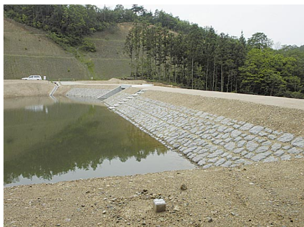
図 6 . 埋土種子を利用した制波工.
