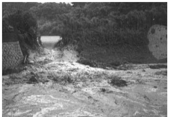
図3．豪雨によるため池の決壊事例.
