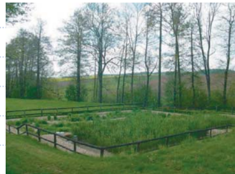
図1 実際に排水処理として使用されている人工湿地
