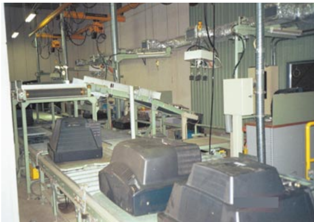
家電リサイクルプラントのテレビ解体工程 リサイクルについては本号の関係記事(2ページ, 3ページ, 9ページ)を参照
