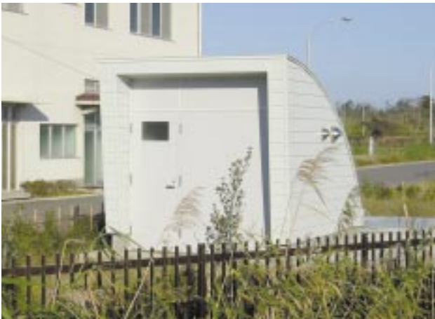
写真2 美浦村の農業集落排水処理施設内の真空ステーション
