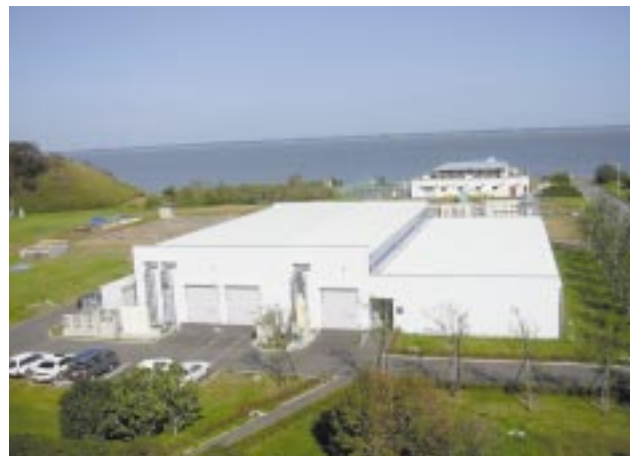
写真1 バイオ・エコエンジニアリング研究施設全景
