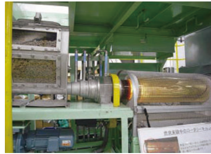
写真2 燃焼試験の様子 試料投入ピットと一次燃焼炉（ロータリーキルン）を撮影したものです。
