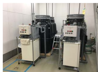
図4 熱帯地域を想定した浄化槽試験
