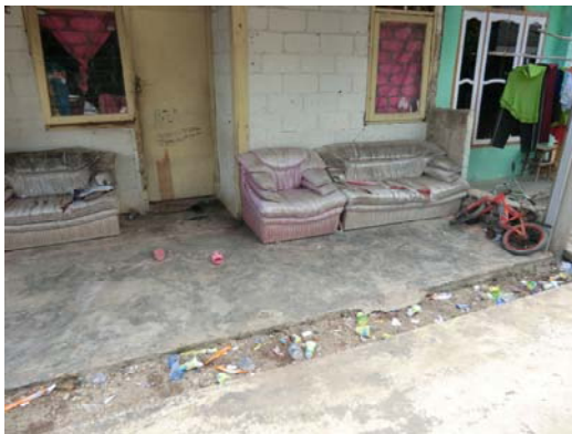
写真 1 ごみで埋まった側溝
