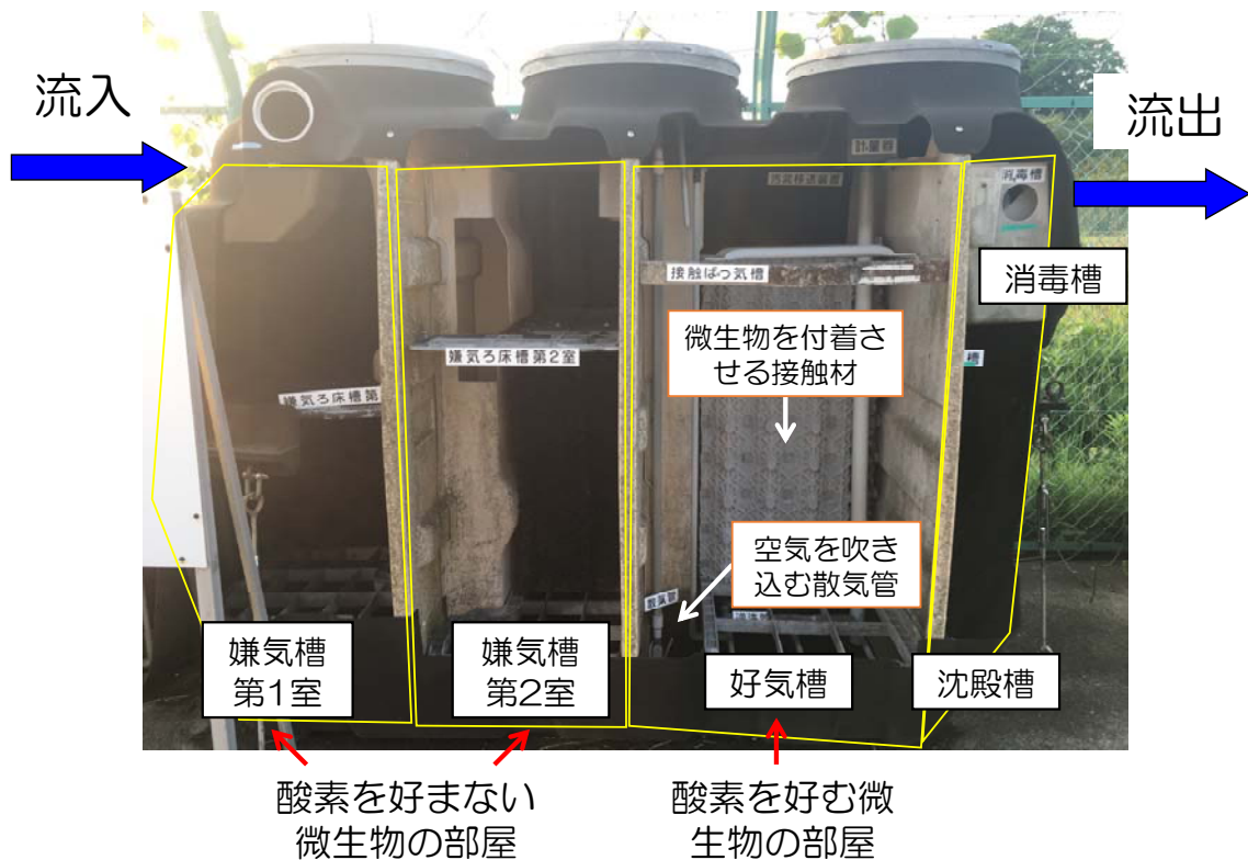
図2 浄化槽の内部構造(例)
