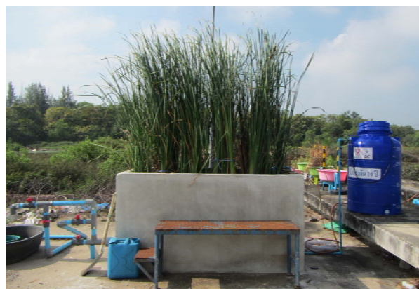
図3 タイの最終処分場に構築した人工湿地装置(横2m, 縦1m, 高さ1m)
