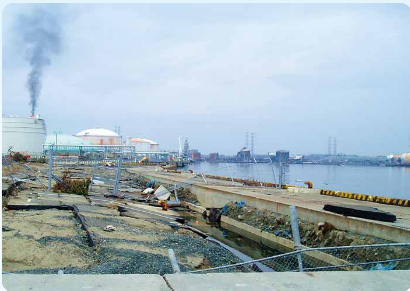
東日本大震災の津波で損傷を受けた仙台新港と製油所(2011年5月1日)
