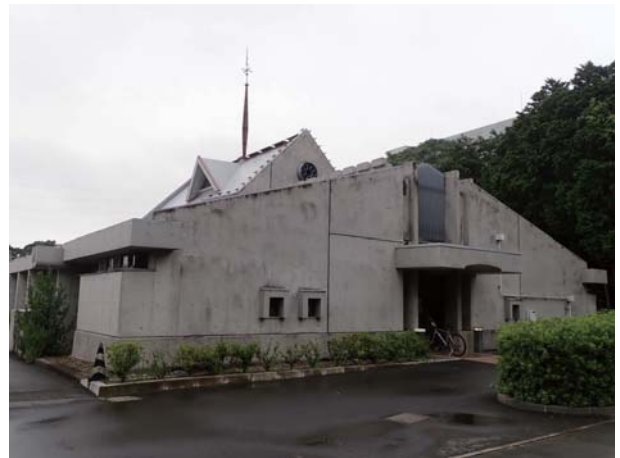
図3 ユニークなデザインの管理棟。この中に実験室、工作室などの設備があります。
