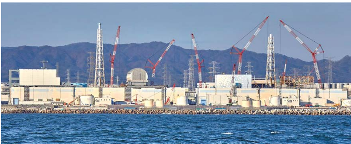
図1 福島第一原子力発電所
