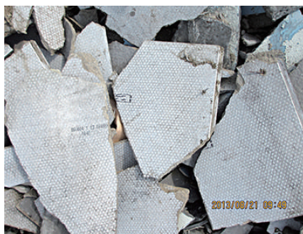
写真1. 災害廃棄物に混入した石綿含有建材
