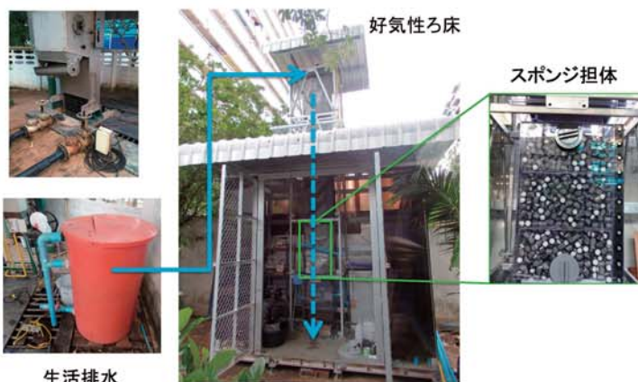
図-3 分散型排水処理技術(DHS)の実証プラント (ボンガイ下水処理場)
