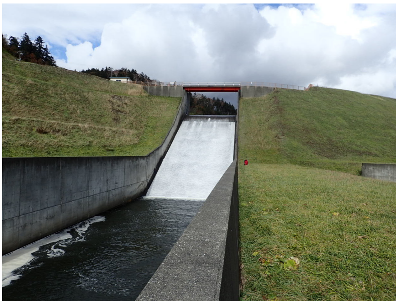
図 12 北辰ダムの放水口と導流堤
