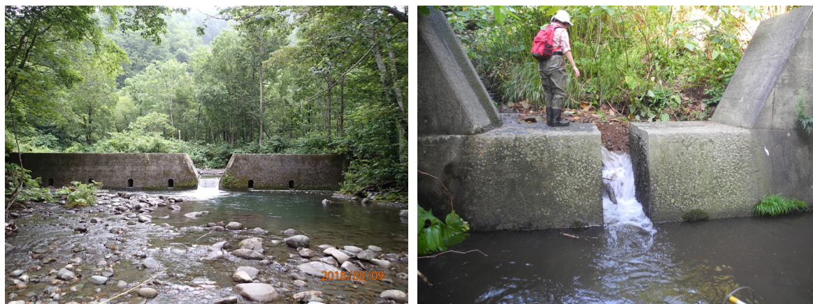
図1 切り下げられた治山ダム (左:石狩川水系の小河川、右:マルヒラ川)
