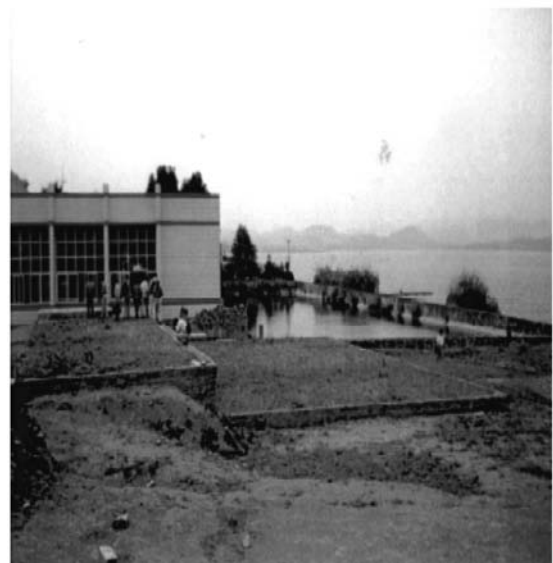
図83 非循環二段式土壌トレンチ法の施工例 (中国貴陽市)
