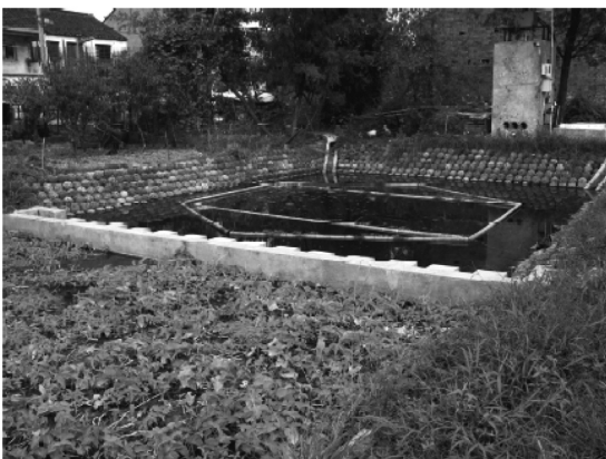
図 85 散水ろ床・人工湿地高度処理法の施工例 (中国宜興市)
