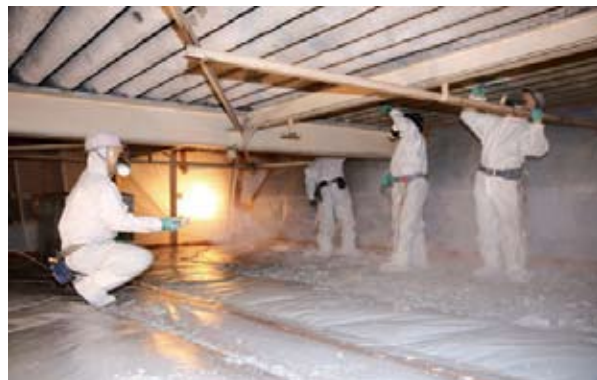
図2 石綿除去作業。マスクの上に、ガムテープで目張りが必要ほど、繊維が細かい。
