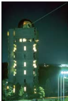
図2 研究所敷地内に設置された大型ライダー（昭和54年）
