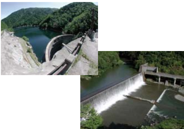
図1 主な河川横断構造物。左上がダム、右下が砂防堰堤
