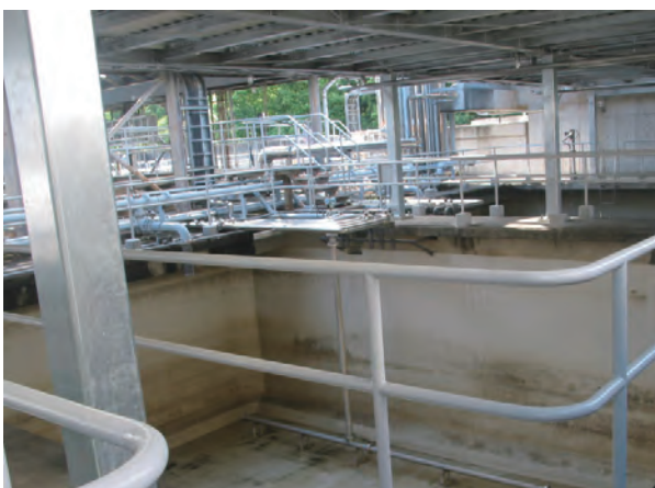
清掃後の一般実験廃水処理施設貯留槽
