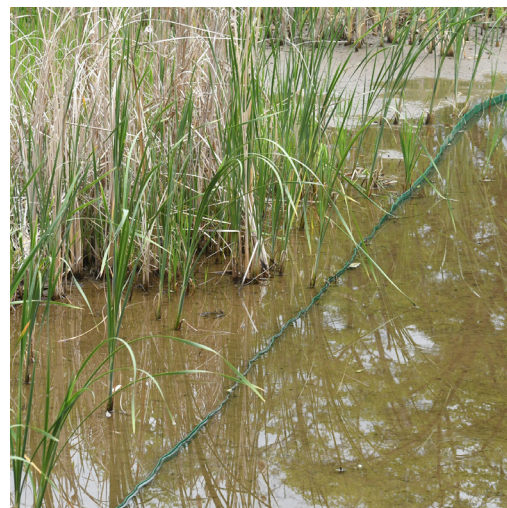
本館横の池の泥に設置した根止め
