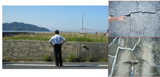
(2) アルカリ骨材反応 (ASR)
