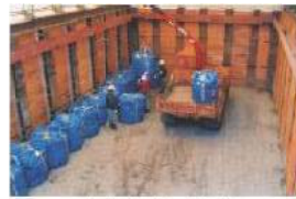
廃棄物定置作業
