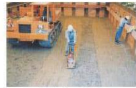
覆土施工状況
